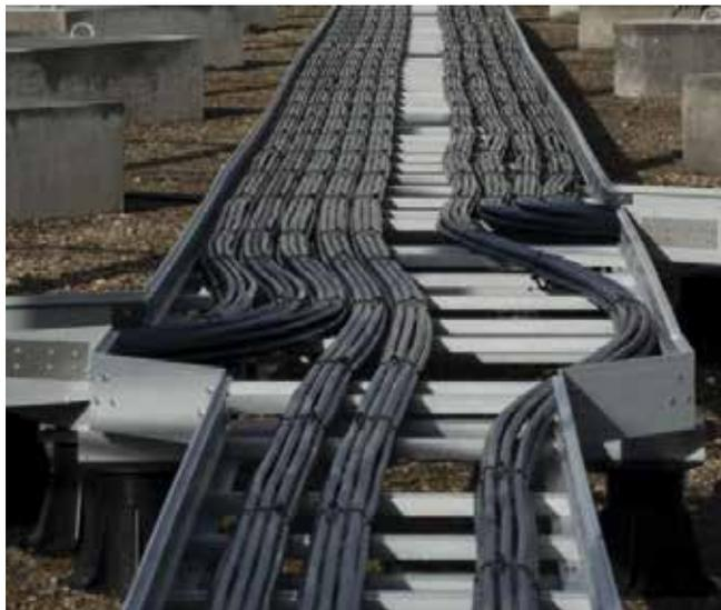
ки и открытой прокладке кабельных линий. Интервал рабочей температуры от минус 60 °С до плюс 160°С. Стеклопластиковые кабельные лотки (короба) устойчивы к агрессивным средам.
