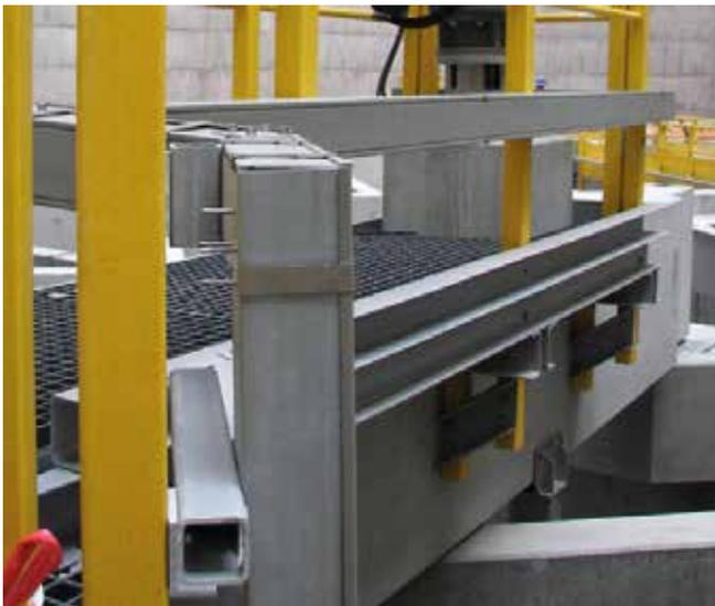
Система стеклопластиковых кабельных лотков (коробов) для электропроводок предназначена для прокладки и защиты проводов, кабелей напряжением до 1000 В при выполнении открытой электропровод-
